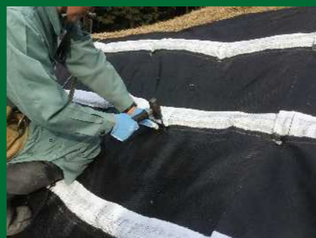
② アンカーピン打設
