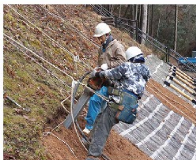
土砂部用アンカー設置状況
