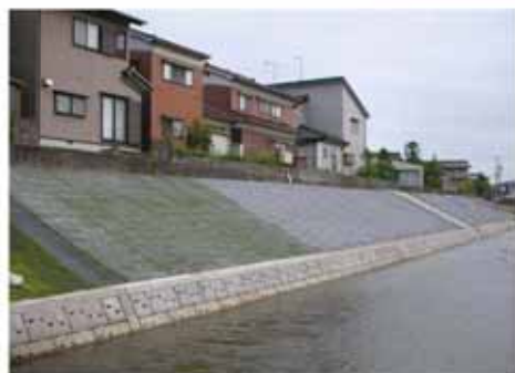
富山県・地久子川 施工直後
