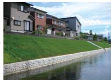
富山県・地久子川 施工後3カ月
